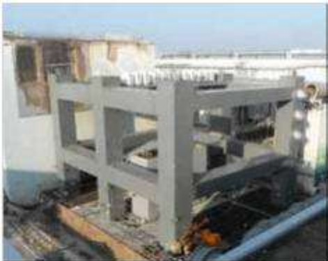
unité 4 superstructure métallique en construction
